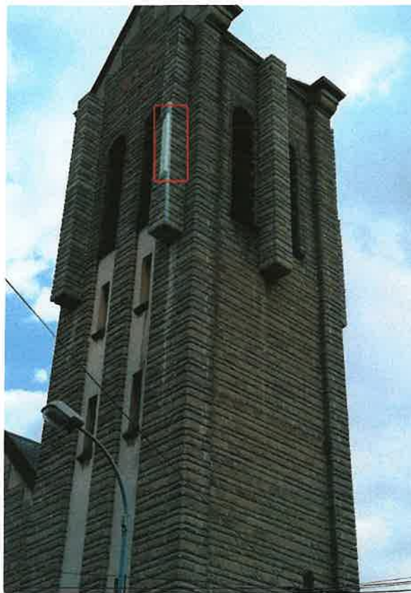
Vue de la terrasse S2 avant travaux
