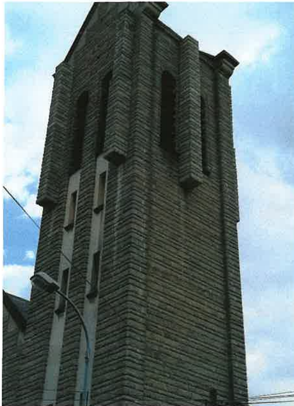
Vue de la terrasse S2 avant travaux
