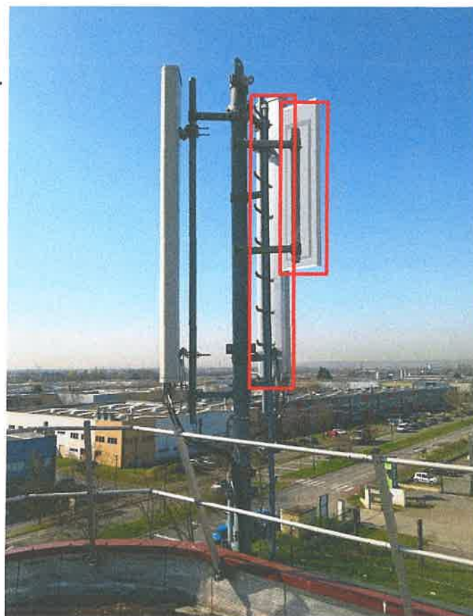
Vue de la terrasse S2 après travaux
