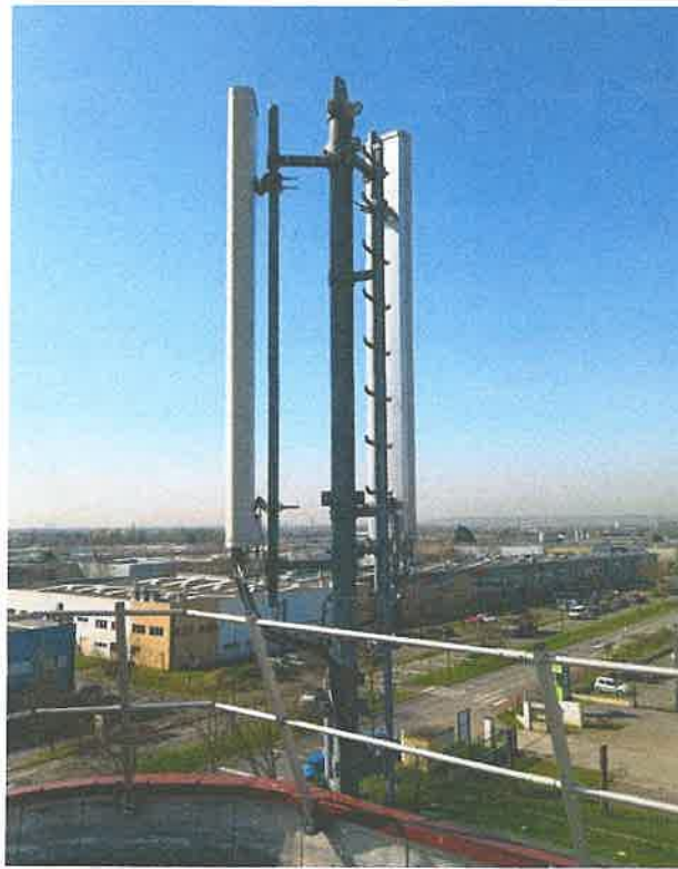
Vue de la terrasse S2 avant travaux
