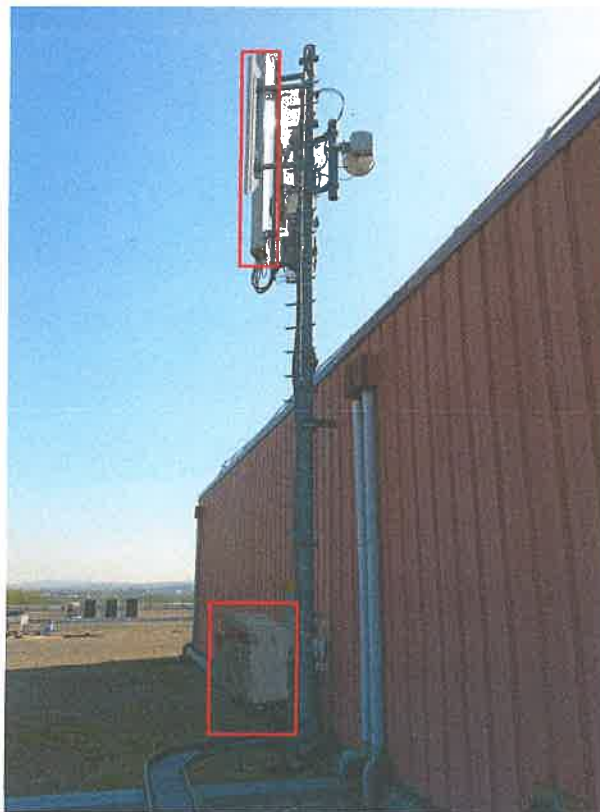
Vue de la terrasse S0 après travaux
